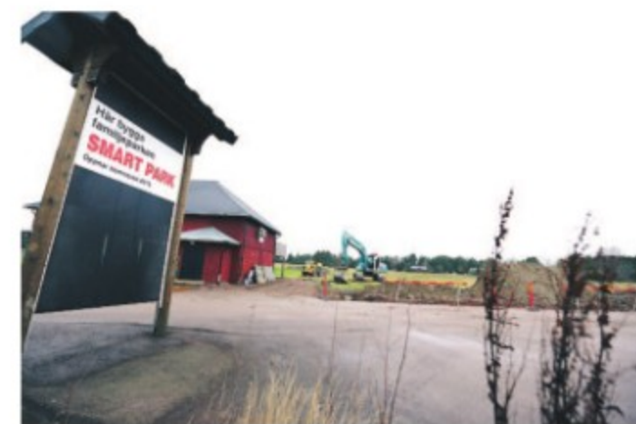
Markarbetena har inletts och den här veckan ska det även gjutas på den tidigare korthålsbanan i Eckerö.
